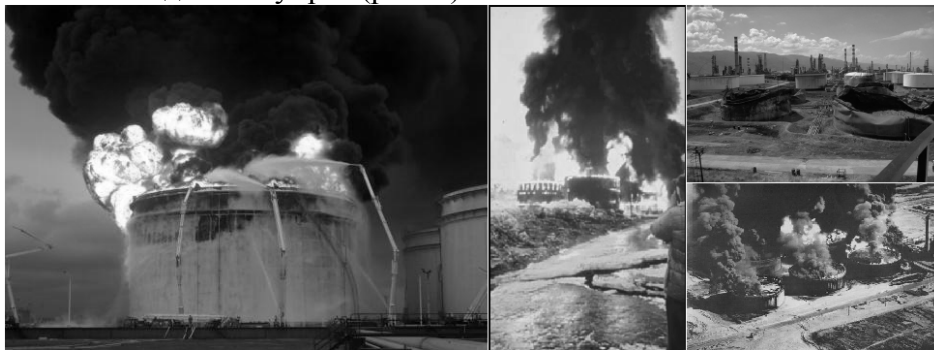
Рисунок 1: Деформация и горение нефтепродуктов в цилиндрическом резервуаре со стационарной крышей после землетрясения в районе Мраморного моря [1]
