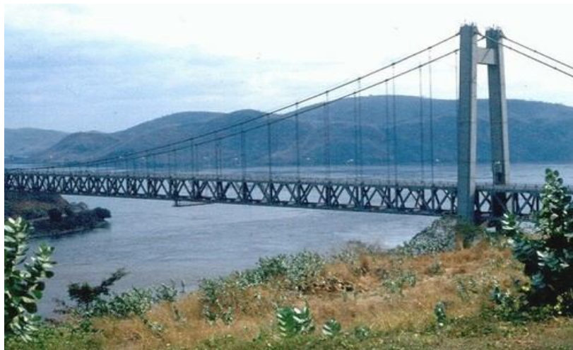
Рисунок 1. Подвесной мост ПОН Маршалль, построенный одной японской компанией в 1983 году.
